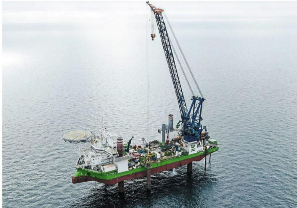
Le « Sea Installer » ancre ses « pattes » au large de la Côte de Nacre.
