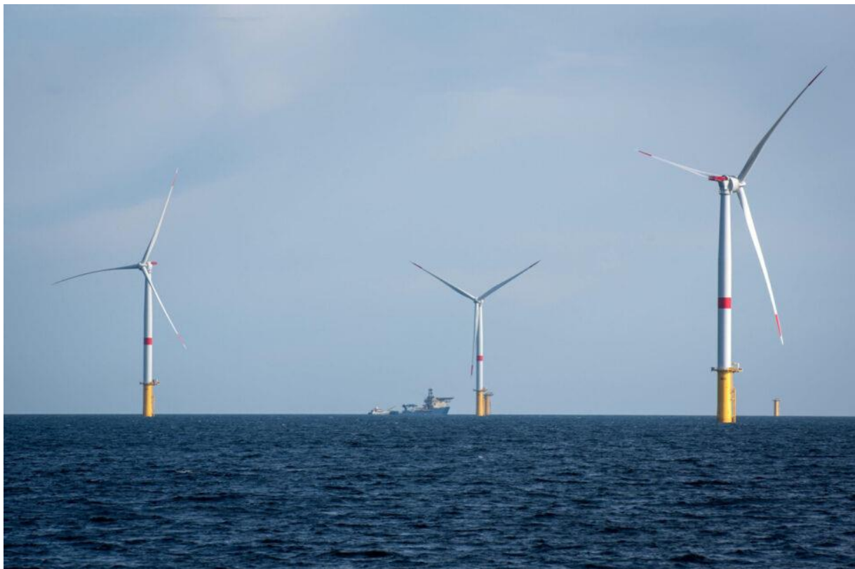
Les 64 éoliennes au large de Courseulles-sur-Mer n'arriveront en mer qu'en 2025. ©EDF Renouvelables
